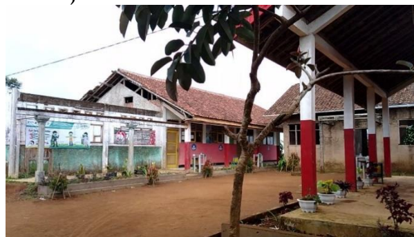
Gambar 1. Kondisi bangunan SDN Sukamakmur
